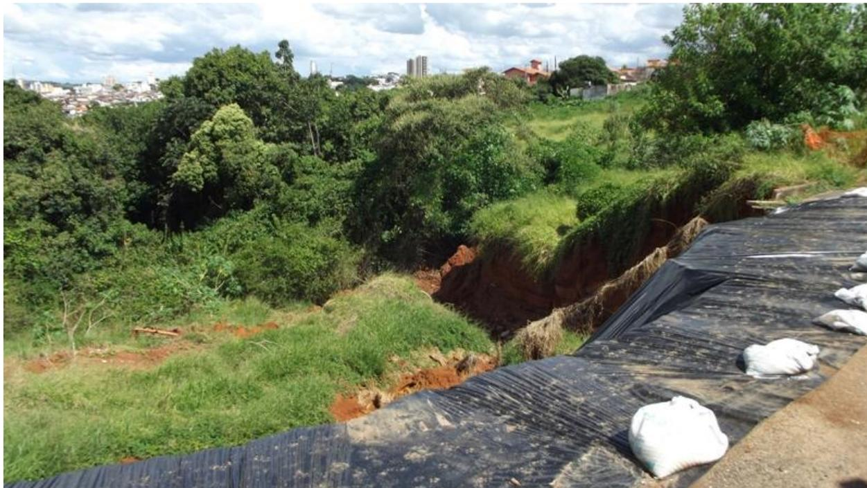
Imagem 6: Medida de contenção do deslizamento
